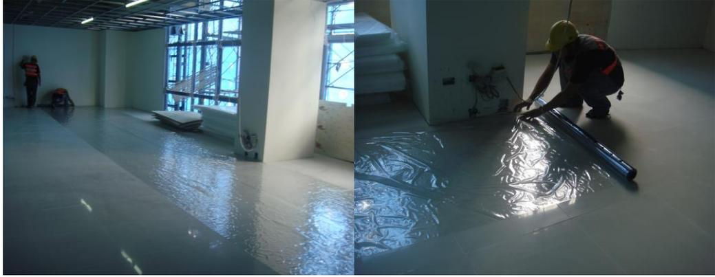
建議：羅馬崗石人造石及羅馬崗石人造石等鋪貼後請以保護膜+瓦楞板+厚紙板、塑膠板保護表面以防其他工程施工造成刮傷或損害
